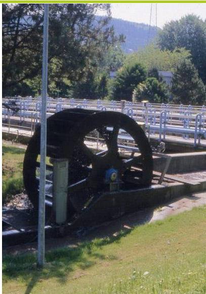
Nagold, (~21200 lakos) Németország szennyvíztelep elfolyó vizére telepített alulcsapott vízkerék, 2 kW-os. Az (öko) turista látnivalók részeként épült.
