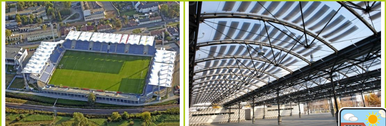
6.30 számú ábra: A ZTE aréna lelátóinak ponyvafedése és ponyvafedésre telepített CIGS napelemek 62,63
