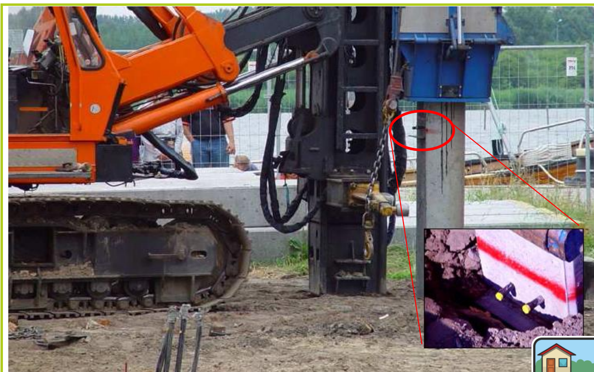
10.9 számú ábra: Előre gyártott vert alap/energiacölöp leütés közben, és kész állapotban (kis kép) láthatóak a hőszivattyú csatlakozás csövei 227
