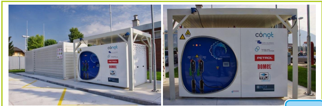
16.21 számú ábra: A Bled-i (Szlovénia) hidrogén töltőállomás, konténeres tárolóegységgel, és kompresszorral. 393 Tárolt hidrogén: 40 kg, 200 bar-on; tankolási kapacitás: 20 kg/nap. Üzemel: 2013. szeptembertől.
