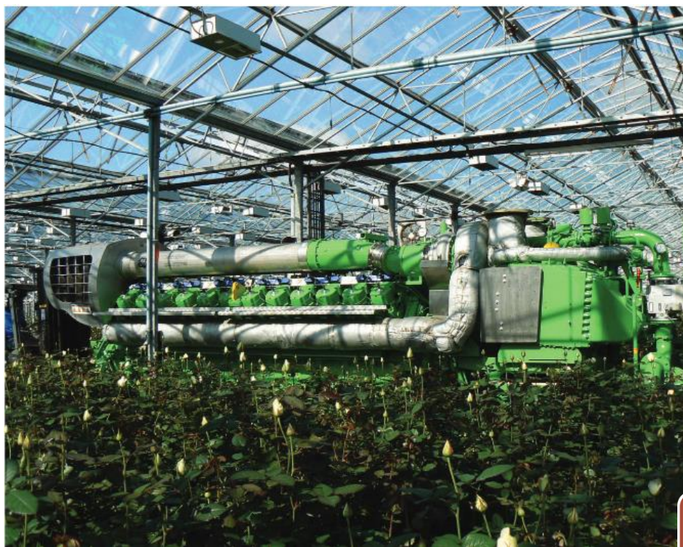
15.5 számú ábra: Jenbacher J624 típusú gázmotor egy holland rózsakertészetben 328
