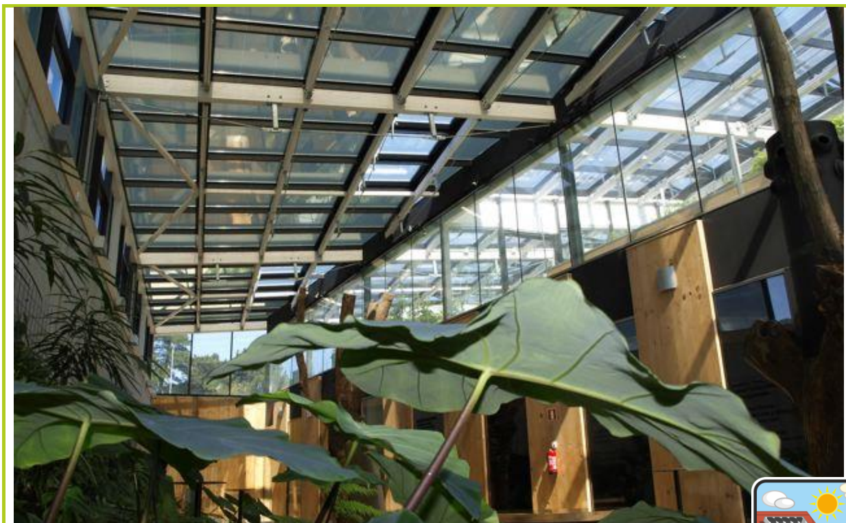
6.31 számú ábra: A várakozó tetején látható üvegfelület egyben napelem is 64
