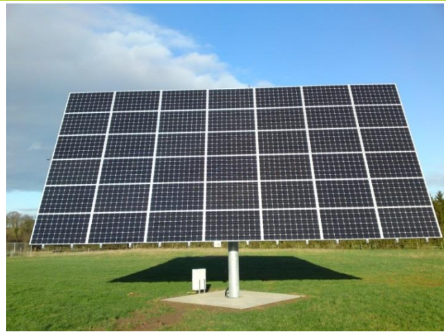
10 kWp naperómű kéttengelyes Deger napkövetőre szerelve 53
