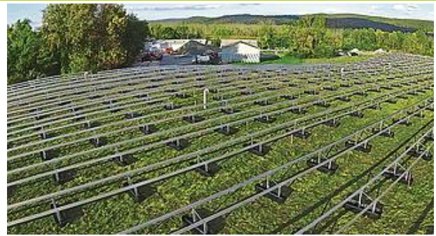
Leterheléses tartószerkezet helyszínen öntött betonelemekkel - a képen zsaluk látszanak.
