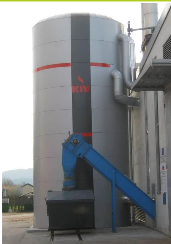
100 m 3 puffer a vranskoi távfűtésben a napkollektorok stagnációs üzemének elkerülésére és a rendszer hatásfok növelésére
