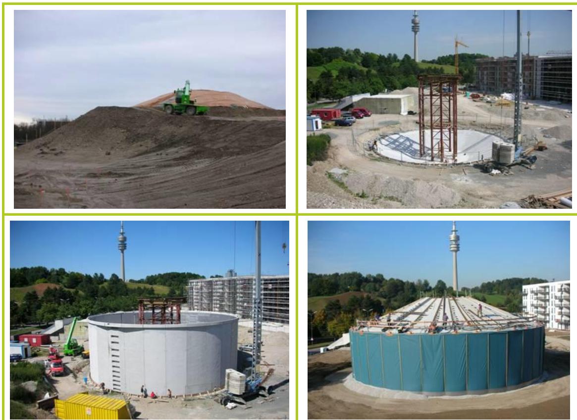
20.14 számú ábra: A müncheni hőtároló tartály építési folyamata 2006-ban 519
