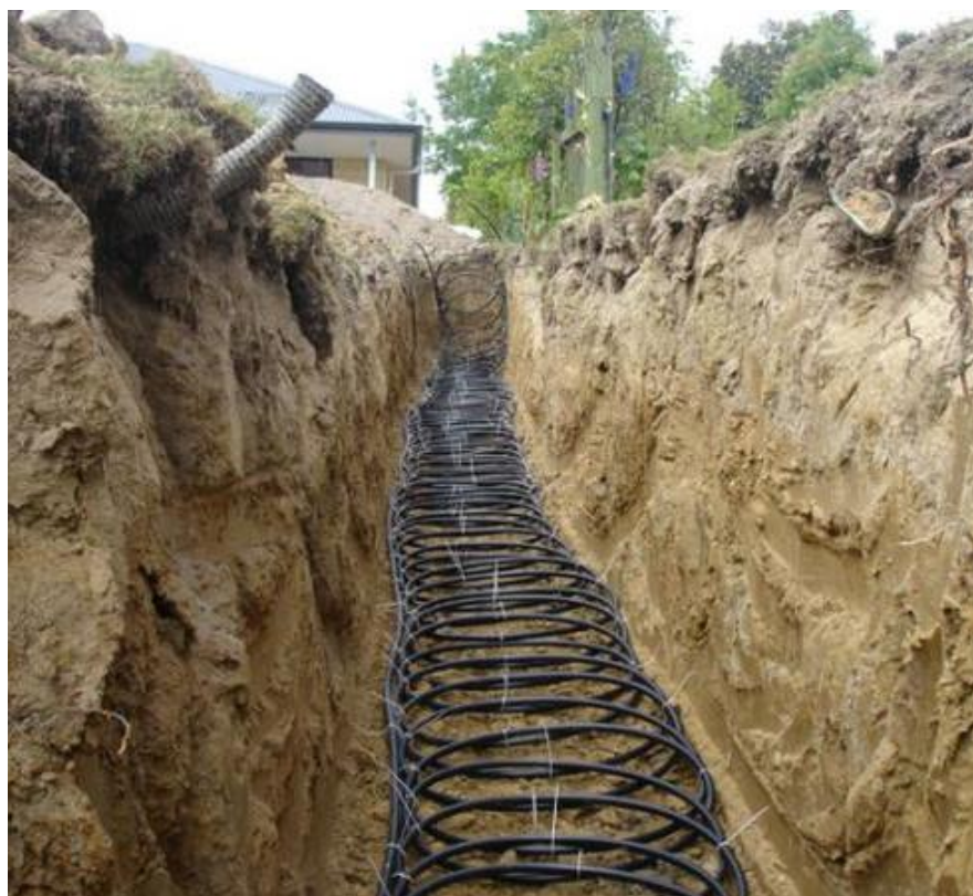
Keskeny telkeknél alkalmazott hőszivattyú hőgyűjtő, 2-2,5x akkora hő gyűjtő terület szükséges, mint a fűtött terület.
