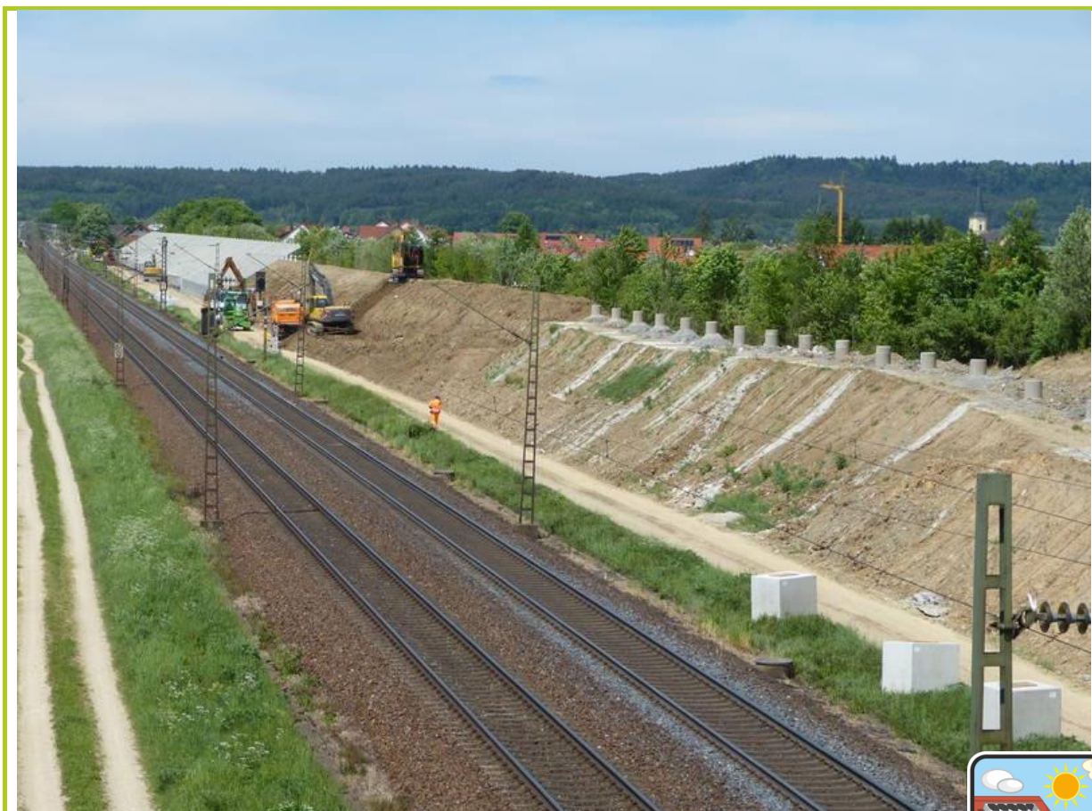
6.11 számú ábra: Zajvédő fal építés alatt
