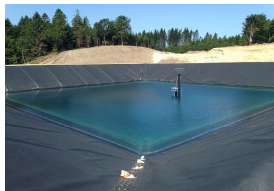
20.19 számú ábra: Egy PTES kialakítási folyamata (burkolás) Dronninglund, Dánia 526
