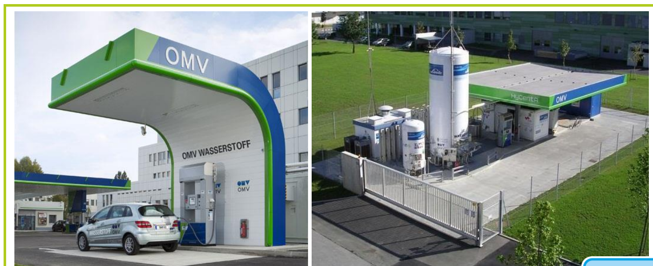
16.31 számú ábra: Bal oldalon: hidrogén üzemanyagtöltő állomás Bécsben (750 bar-os), egy hagyományos benzinkútnál telepítve és egy HFC személyautó 419 ; Jobb oldalon: hidrogén tároló és töltőállomás Grazban 420
