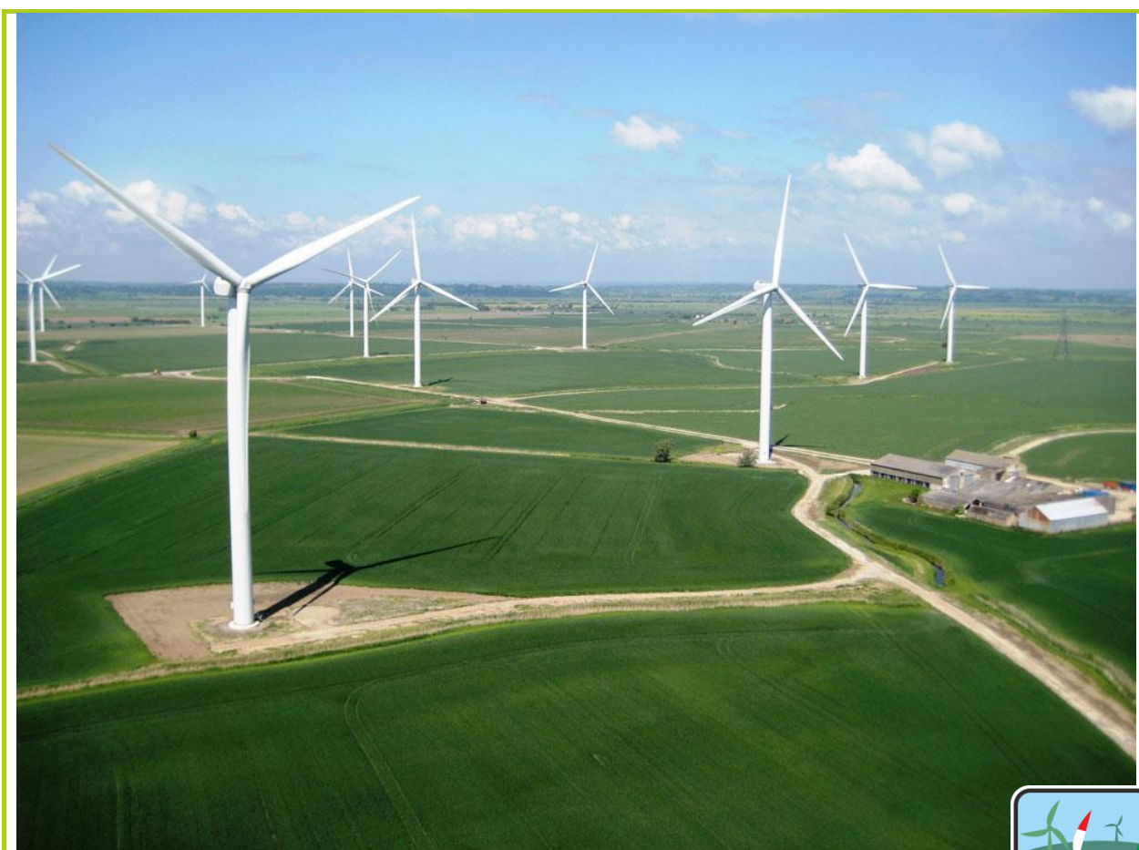
7.3 számú ábra: A szélerőművek karbantartását szerviz-utakkal kell biztosítani 95
