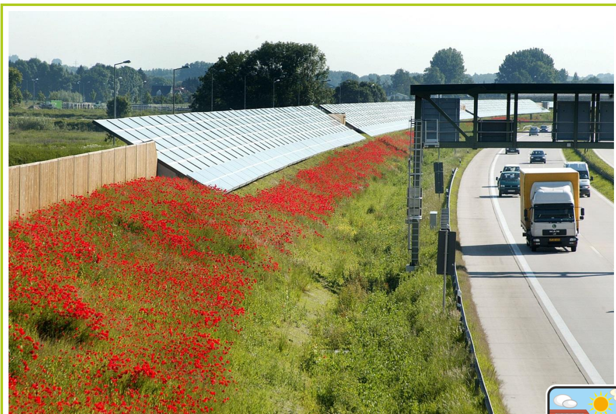
6.12 számú ábra: 594 kWp teljesítményű épített zajvédőfal A92 Autópálya Freising melletti szakasza ~750m
