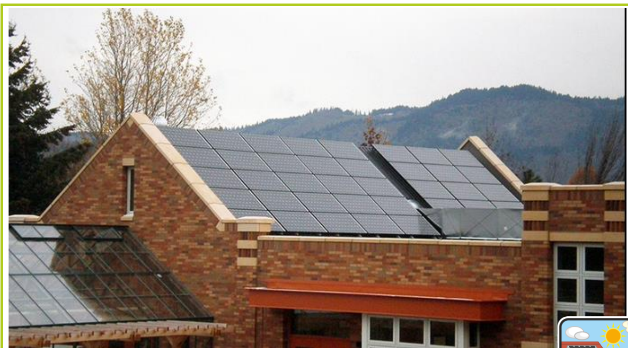
6.33 számú ábra: Hibrid, levegő előfűtő PV-t kollektor 69
