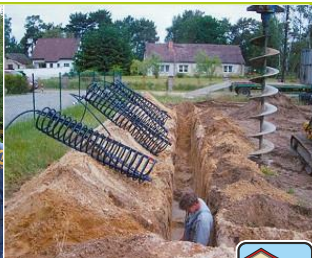
Spirálkollektorok telepítés közben 219
