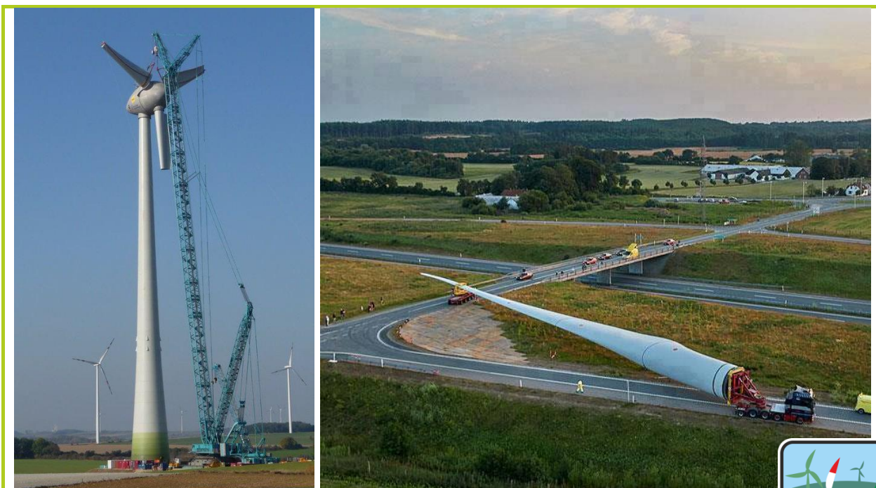
7.7 számú ábra: A korszerű szélenergia-berendezések (a képen E-126) lapátját a szállítás megkönnyítése érdekében több darabból szerelik össze
