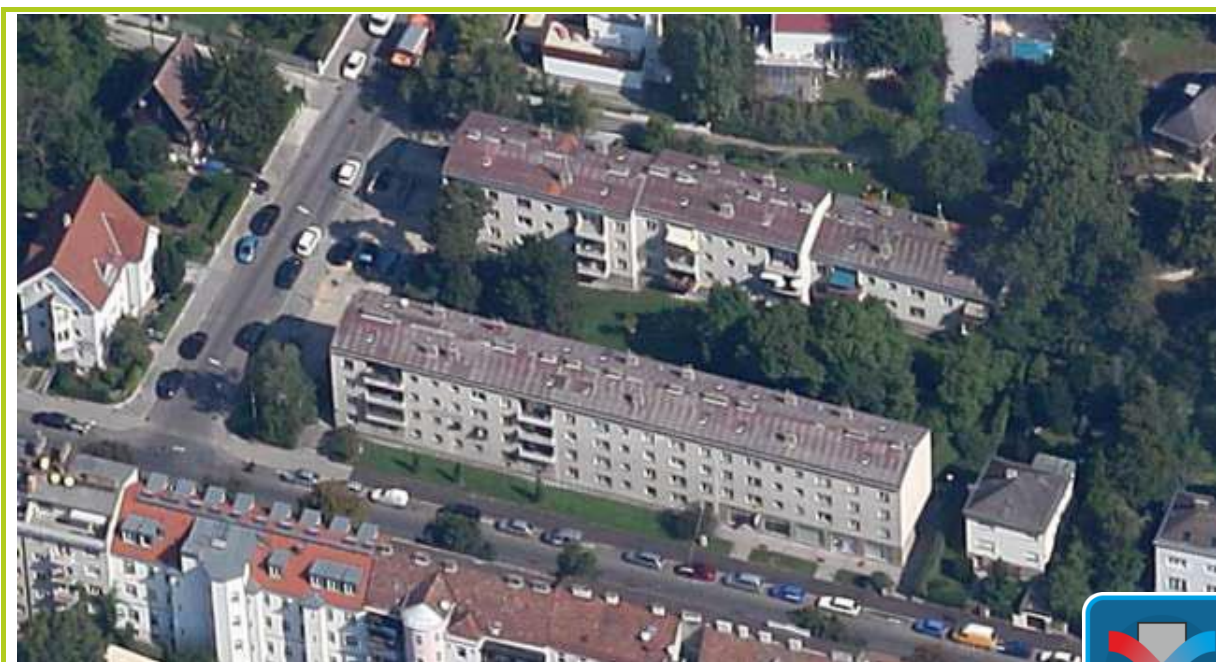
9.38 számú ábra: A társasház felújítás előtt
